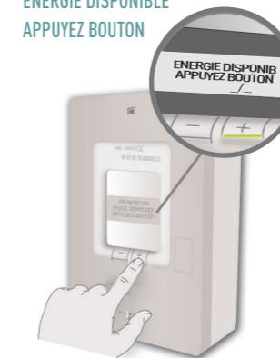
Trop d'appareils électriques utilisés en même temps peuvent avoir causé un dépassement de puissance. Mettez hors tension ces appareils afin de revenir à la puissance souscrite. Puis appuyez 5 à 10 secondes sur le bouton "+". Si l'électricité ne revient pas ou recoupe, vous n'avez pas mis suffisamment d'appareils hors tension. Renouvelez l'opération.
